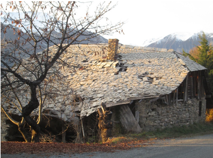
Toit d'ardoise à Saint André d'Embrun
