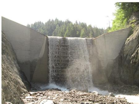
*Illustration 11: Le barrage Poncet, la partie centrale du barrage est un assemblage de pierres et de troncs de mélèzes*
