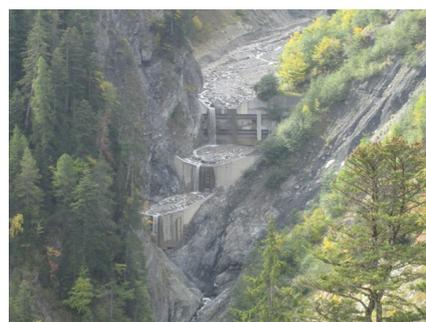
*Illustration 14: Le barrage B1 et ses deux contre-barrages dans le lit du torrent de Bragousse*
